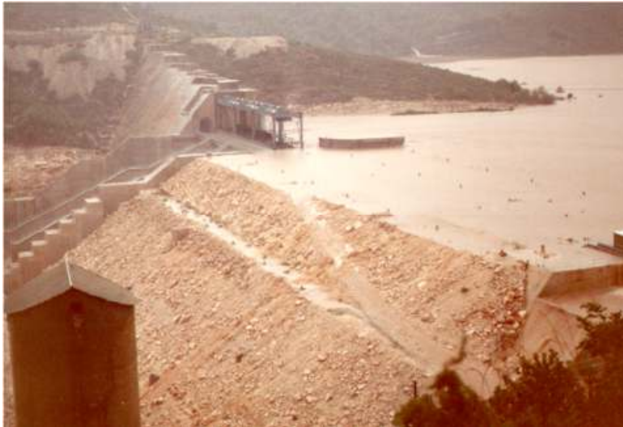
Presa de Tous instantes previos a su rotura en 1982 Fuente: Conf. Hidrográfica del Júcar
